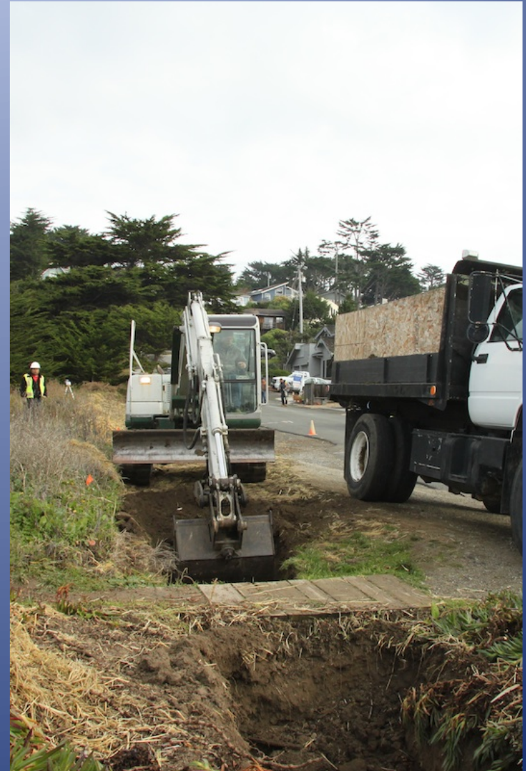
Juliana Ave Trench
